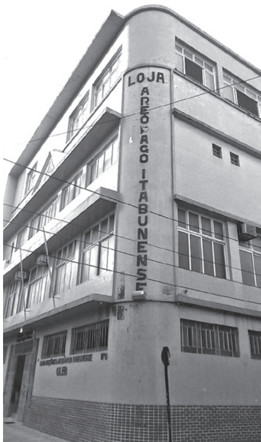
Fachada atual da A.R.L.S. Areópago Itabunense
