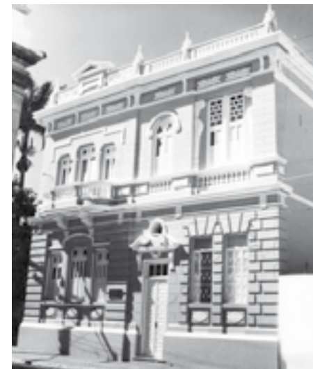
Fachada da Loja Maçônica Regeneração Sulbaiana/Palacete Misael Tavares
